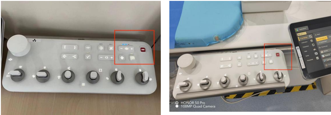
图3-4 本项目 DSA 机房控制室及机房内设备操作面板上急停按钮
