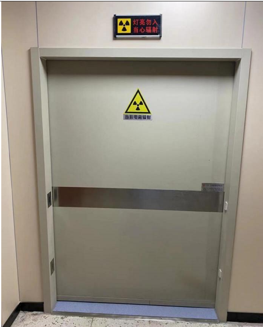
图3-2 本项目DSA机房工作状态指示灯和电离辐射警告标志
