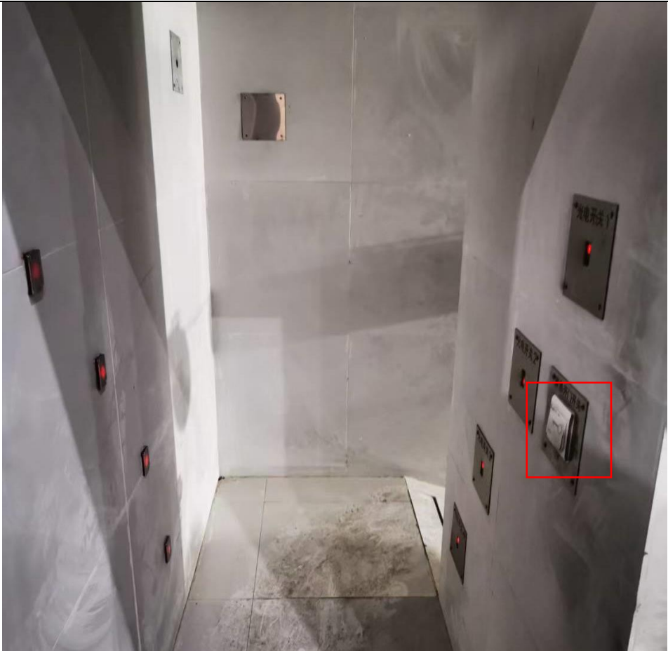
图3-12 光电防人误入装置及强制开门按钮
